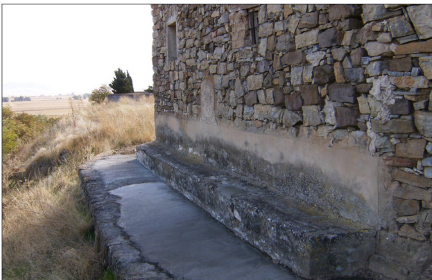
Banco de la Nevera en Trévago
