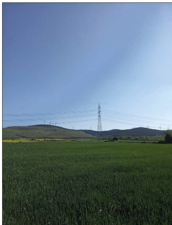
En muchos lugares esos cables van soterrados
